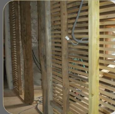
**6.** **Cloison et murs :** clouer le lattis entièrement sur l'une des faces de l'ouvrage. Sur l'autre face, clouer sur 50 cm de hauteur. **Doublage :** clouer les lattes sur 50 cm de hauteur.
