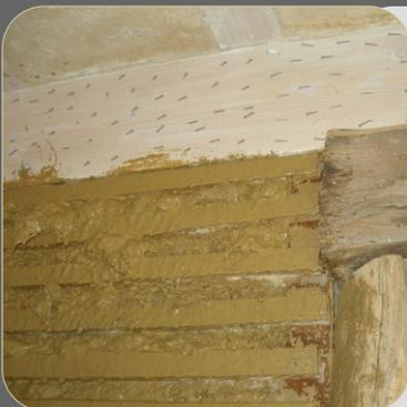
**9.** Pour recouvrir d'enduit des matériaux non-compatibles comme des éléments en bois, les recouvrir de clous et appliquer une première couche d'enduit.
