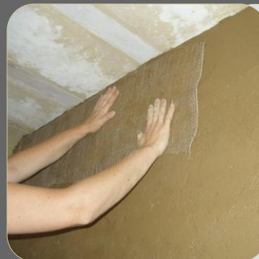
**10.** Intégrer de la toile de jute dans l'épaisseur de l'enduit sur cette zone, en dépassant largement de toutes parts. Faire de même sur les zones à risque de fissuration.
