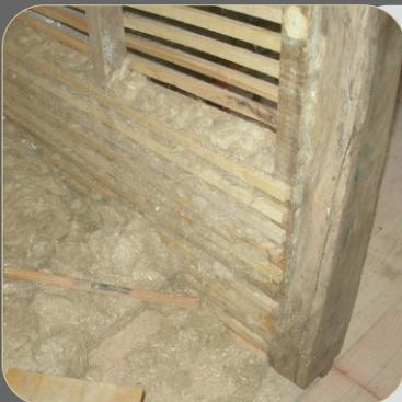
**7.** Procéder au remplissage, par couches successives, en tassant de manière adaptée au matériau choisi. Alternier clouage et remplissage jusqu'en haut.
