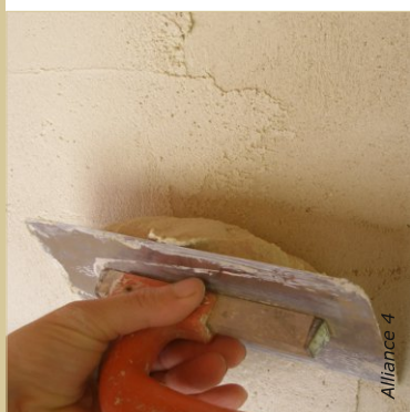
La seconde couche est appliquée sur la première déjà ferme sous la pression du doigt.
