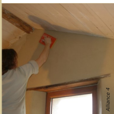
La taloche-éponge permet de réhumidifier l'enduit et d'égaliser les surépaisseurs aux reprises.
