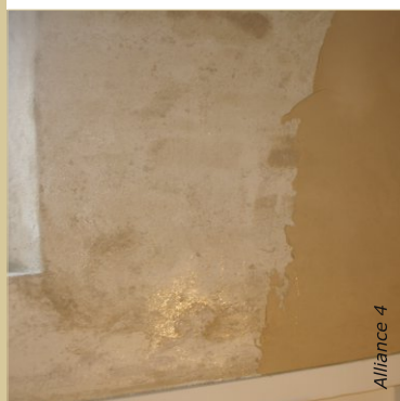
L'humidification des supports poreux est une étape importante pour la réussite de l'application et pour la carbonatation de la chaux.
